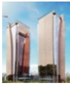
Edifício EZ Towers São Paulo, Brasil LEED Gold
